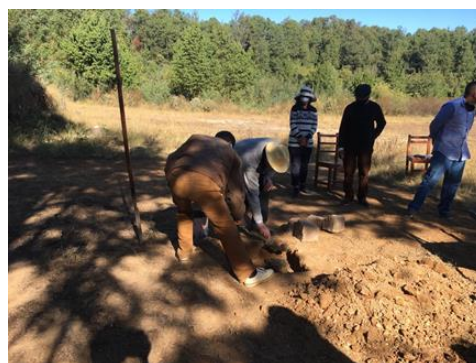
Pose de la première pierre de la briqueterie
